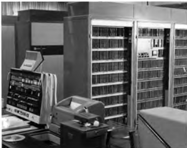
Рис. 4.10. Пульт управления и арифметическое устройство машины Atlas
